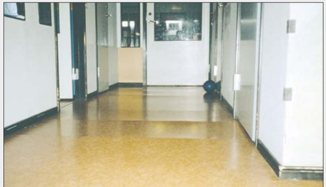
Betonilaatasta lattianpäällysteeseen päässyt kosteus on turvottanut maton saumat ja hajottanut liiman koostumuksen, minkä vuoksi muovimaton alle on syntynyt ilmakuuplia.
